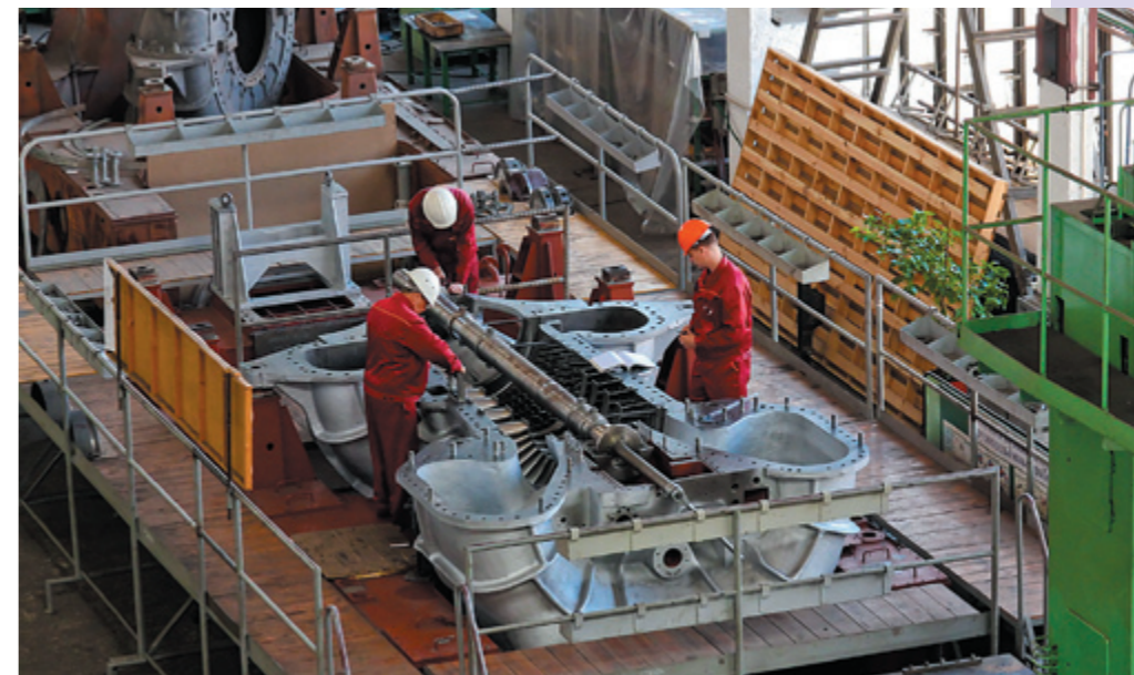
Блочный ремонт газовых турбин
