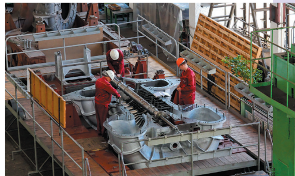
Блочный ремонт газовых турбин
